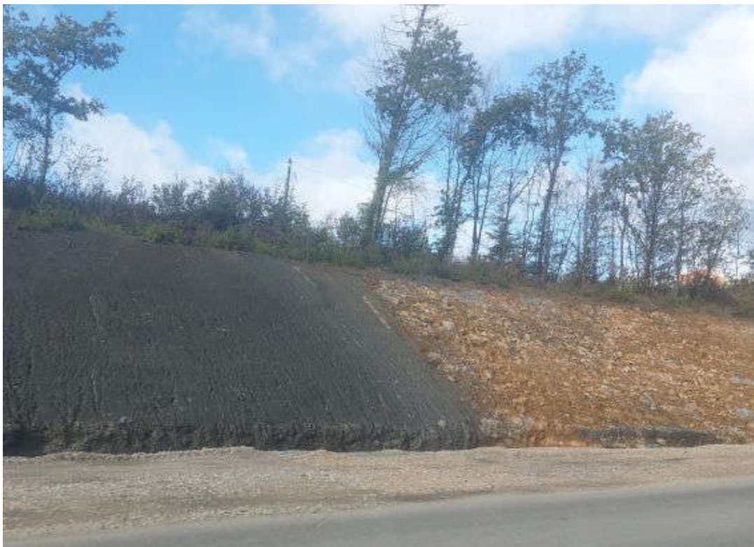
Faille mettant en contact les Grès de Luxembourg et le faciès marneux le long de l'autoroute, près de Berchem, Luxembourg.
