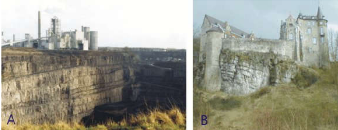
A : Formation d'Antoing exploitée dans la carrière du Milieu, à Gaurain-Ramecroix (ASH). B : château de Mielmont, près de Onoz, bâti sur les dolomies du Groupe de Namur. Parautochtone brabançon.
